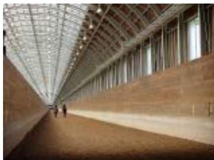
写真 7. 屋内直線馬場
