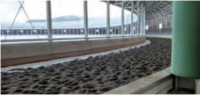
写真3 冬期間の屋内トラック 雪が吹き込んだ場合、溶けた水が凍結リスクになります。この時は人力で除雪し、塩化カルシウムを300kg散布しました。
