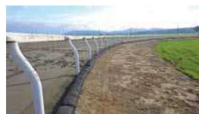
図2 南側コーナー 内向き1.5%の傾斜をつけ、路肩を下げて水はけを良くしました。
